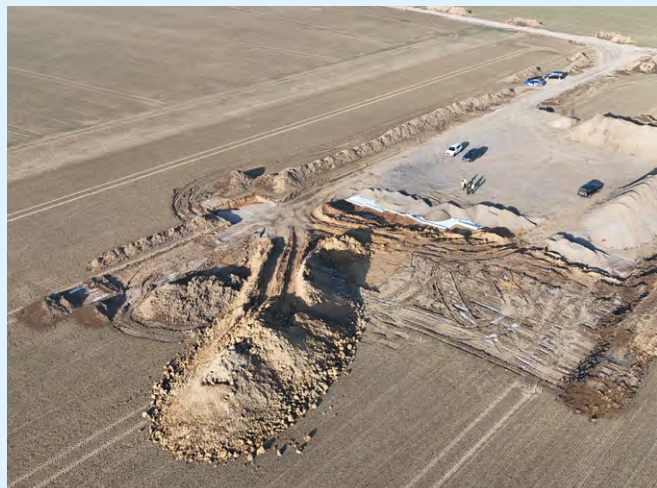
Erd- und Fundamentarbeiten für den Windpark Hanstedt II: Die Basis für die neuen Enercon-Anlagen entsteht.
