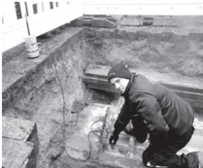
Korrelation: Adrian Duraku setzt das Mikrofon auf die Rohrleitung, um den Schall, der durch die Leckage verursacht wird, einzumessen.
