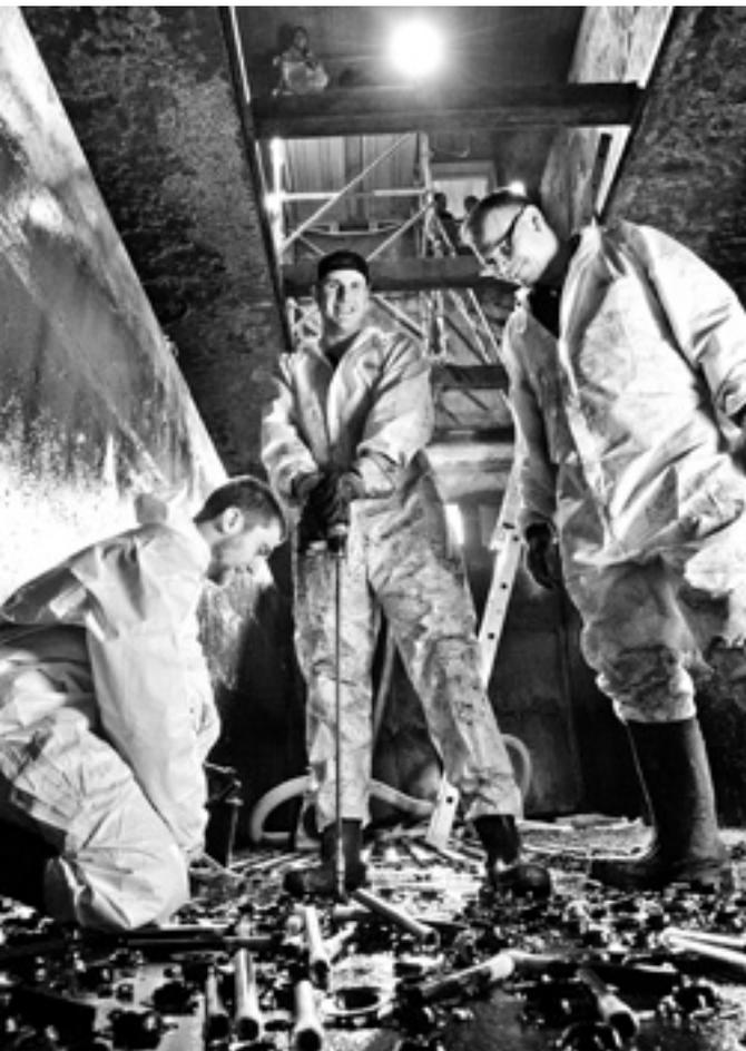
Wartungsarbeiten: Mitarbeiter der Kieler Stadtwerke erneuern ein Filterbecken im Wasserwerk Schulensee. Der erste Bauabschnitt der Sanierung ist nun abgeschlossen.
