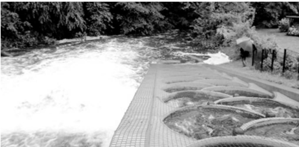
Vollkommen durchlässig: Mit dem Bau eines weiteren Mäanderfischpasses wird die europäische Wasserrahmenrichtlinie erfüllt. Insgesamt 19 Becken mit jeweils zwei Metern Durchmesser ermöglichen den Fischen dann freien Weg bis in die Kieler Förde. Hier der bereits bestehende Pass am Altarm der Schwentine.
