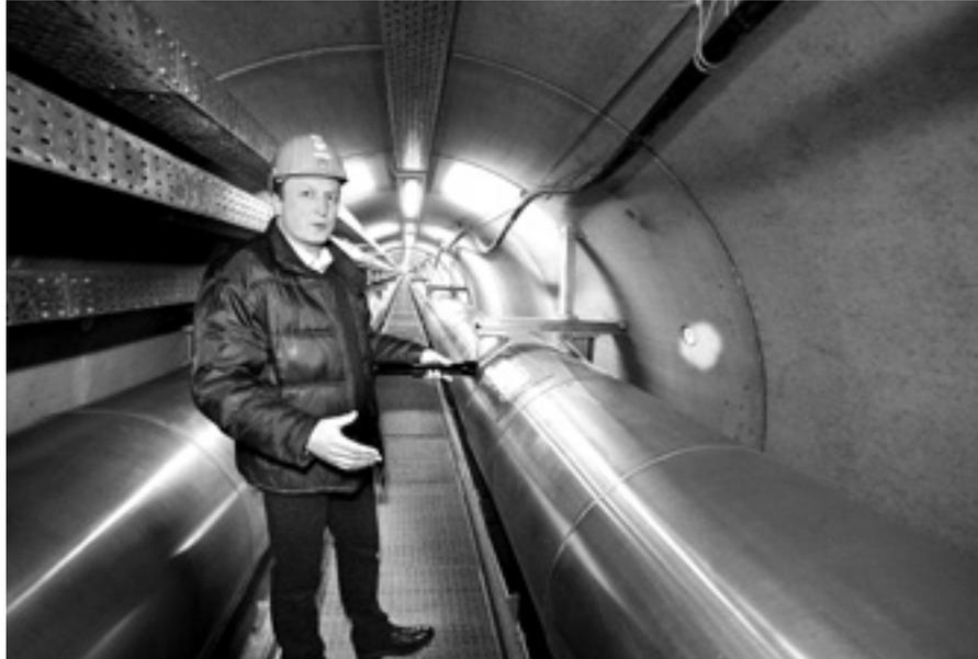
Technische Präzisionsleistung: Im Rahmen der Sanierung wurden 450 jeweils drei Meter lange und 30 Tonnen schwere Tunnelsegmente aus Spezialbeton auf der Ostseite des Bauwerks neben dem Gemeinschaftskraftwerk abgesenkt. Diese wurden dann mit Hydraulikpressen durch den Tunnel geschoben, bis der Tunnel eine neue Innenröhre hatte. Projektleiter Jörn Paulat beschreibt die Arbeiten.
