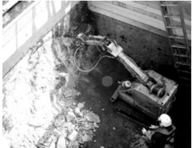
Sanierungsarbeiten: Die seitlichen Wände, die über dem Wasser liegende Stauwand und die Natursteinrampe unter Wasser werden vollständig erneuert.
