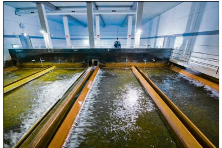
*Gut gefiltert: Über das Kiesbett werden die Eisen- und Manganflocken aus dem Wasser zurückgehalten.*
