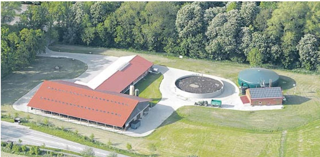
*In der Biogasanlage in Futterkamp dient Methan – aus Gülle und Maissilage erzeugt – als Betriebsenergie für das Blockheizkraftwerk.*
