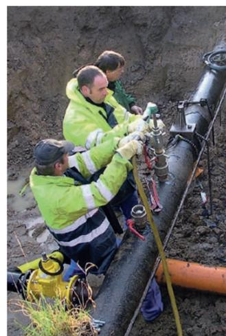
Schweißarbeiten im Zuge von Einbindungsarbeiten neuer Gasleitungen an der Baustelle der B76.
