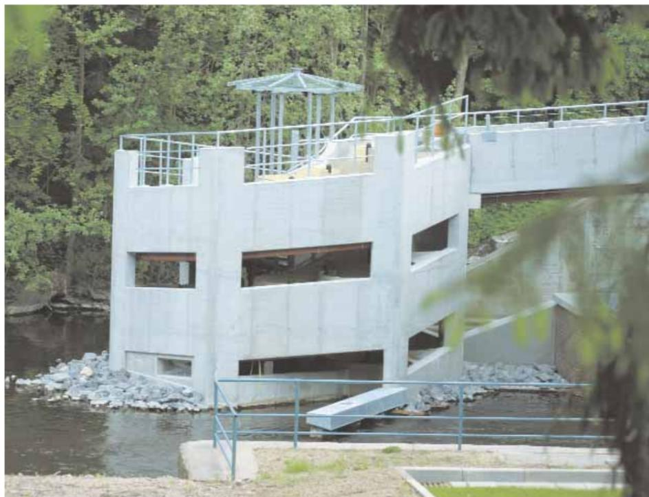
*Weltweit einmalig: Der „Helix-Turmfischpass“ am Wasserkraftwerk Raisdorf ermöglicht es den Fischen, die Schwentine hoch oder hinunter zu wandern.*
