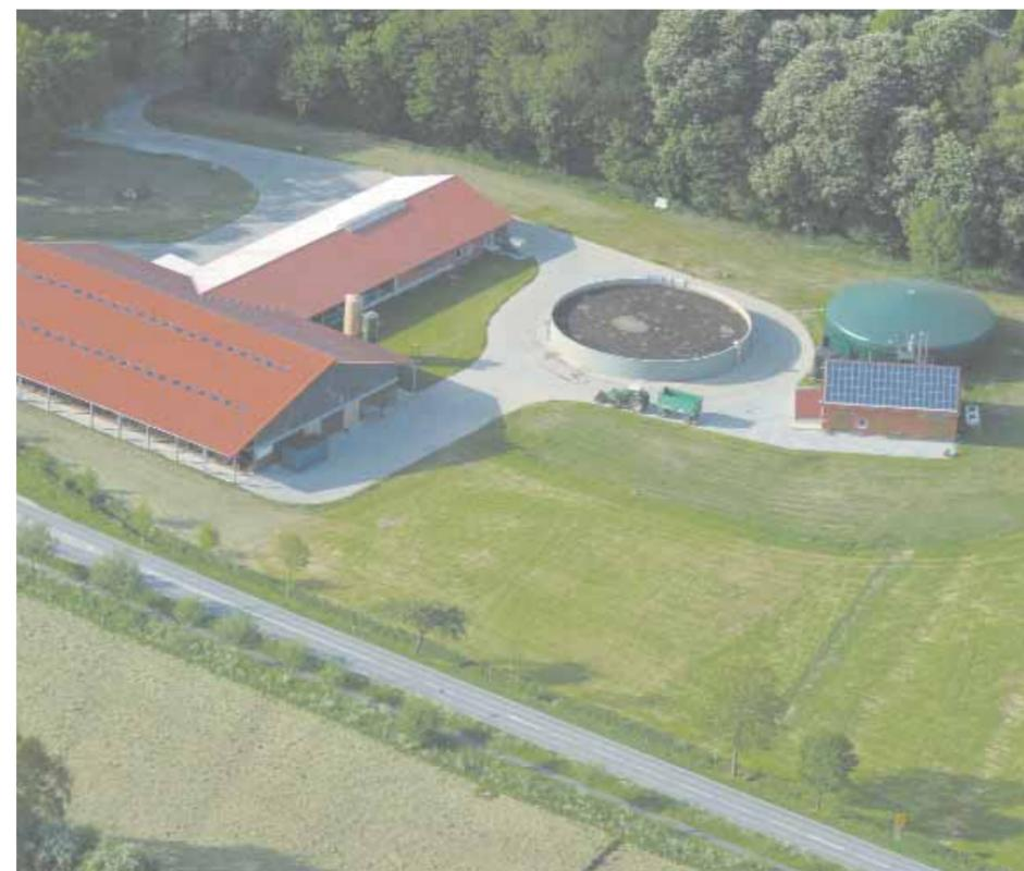
In der Biogasanlage in Futterkamp dient Methan – aus Gülle und Maissilage erstellt – als Betriebsenergie für das Blockheizkraftwerk.
