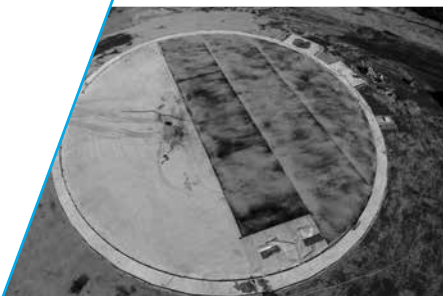
Fundament Wärmespeicher fertiggestellt
