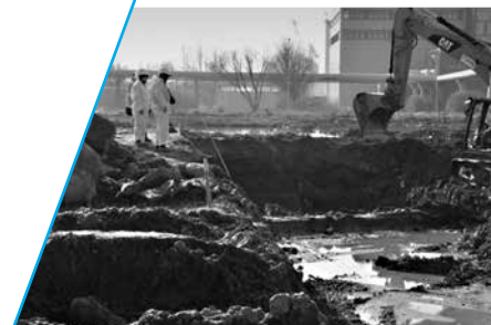
Kampfmittelräumung und Baufeldvorbereitung
