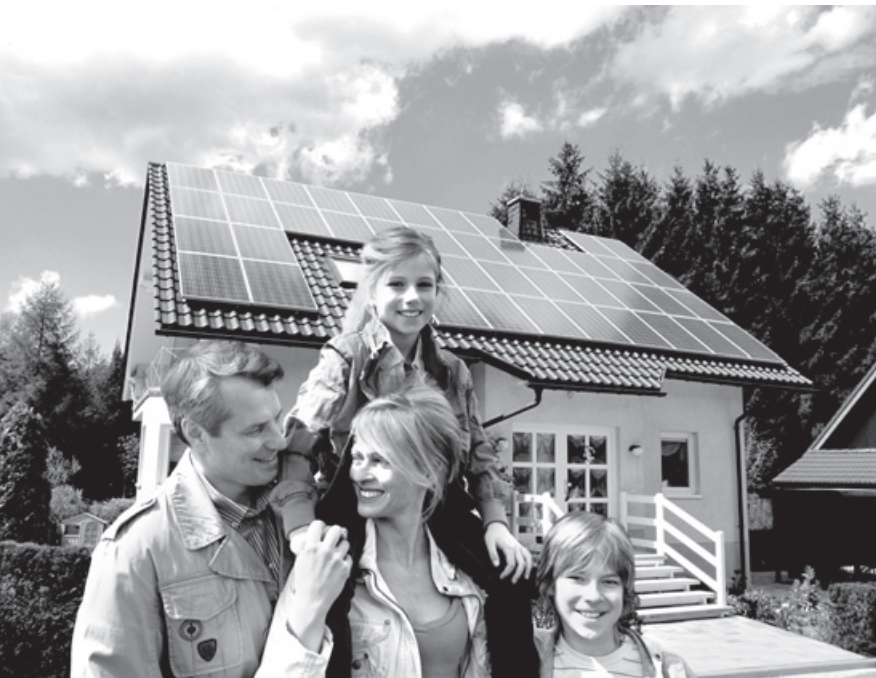
Bequem den eigenen Strom erzeugen und dann im Sonnenspeicher speichern: Eine sinnvoll dimensionierte Photovoltaik-Anlage macht es möglich.
