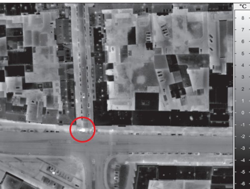
Rohrbruch: Die Baustelle in der Düppelstraße, Ecke Holtenauer Straße war zum Zeitpunkt des Überfliegens noch nicht geschlossen.
