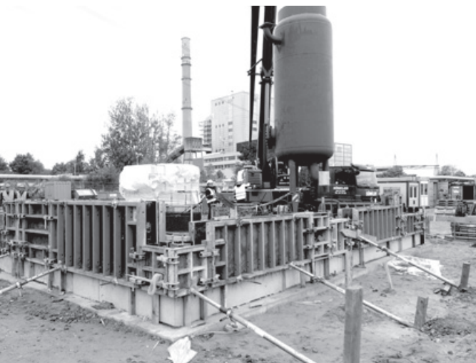
Der Elektrodenkessel wird aufgestellt: In der sechs Meter hohen Anlage kann bei Bedarf mittels Strom Fernwärme erzeugt werden.
