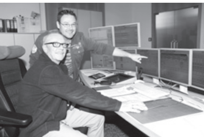
Fehlermeldung: Alle Störungen gehen in der Leitwarte der Stadtwerke ein. Peter Bayer und Rainer Krause (v.l.) reagieren sofort.
