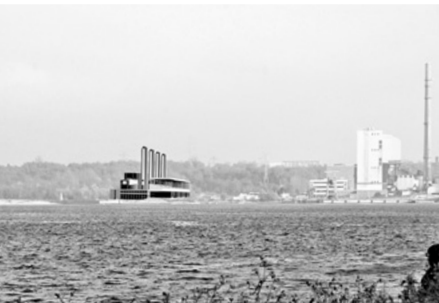
Neubau: Bis spätestens 2016 wird ein umweltfreundliches und flexibles modulares Kraftwerk das mittlerweile 40 Jahre alte Gemeinschaftskraftwerk ersetzen.
