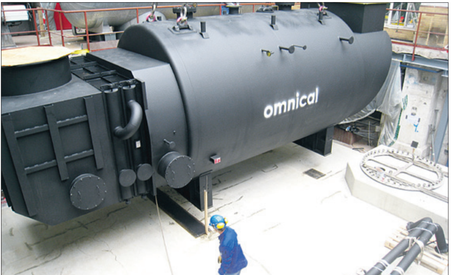
Für eine zuverlässige Versorgung mit Fernwärme: Das Heizkraftwerk Humboldtstraße wird momentan durch zwei neue Gasturbinenanlagen modernisiert. Die Abhitzeessel sind bereits eingebaut.
