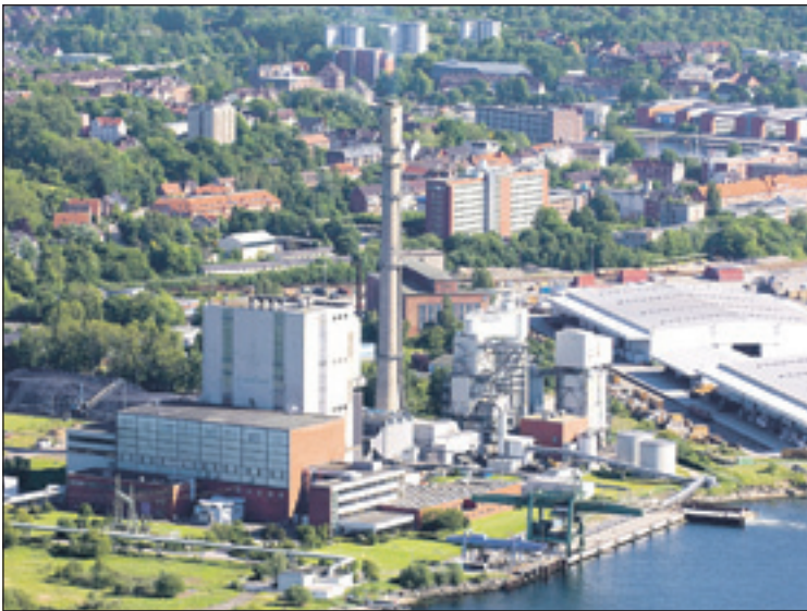
Das Gemeinschaftskraftwerk Kiel (GKK): Die Anlage erzeugt Strom und Wärme. Sollte die Kooperation mit Neumünster klappen, könnte auf eine Lebensdauerverlängerung verzichtet werden.
