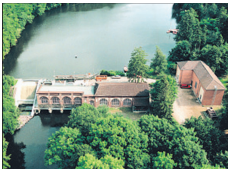
Die Natur hat sich mit dem Kraftwerk arrangiert: Das Wasserkraftwerk II am Rosensee.
