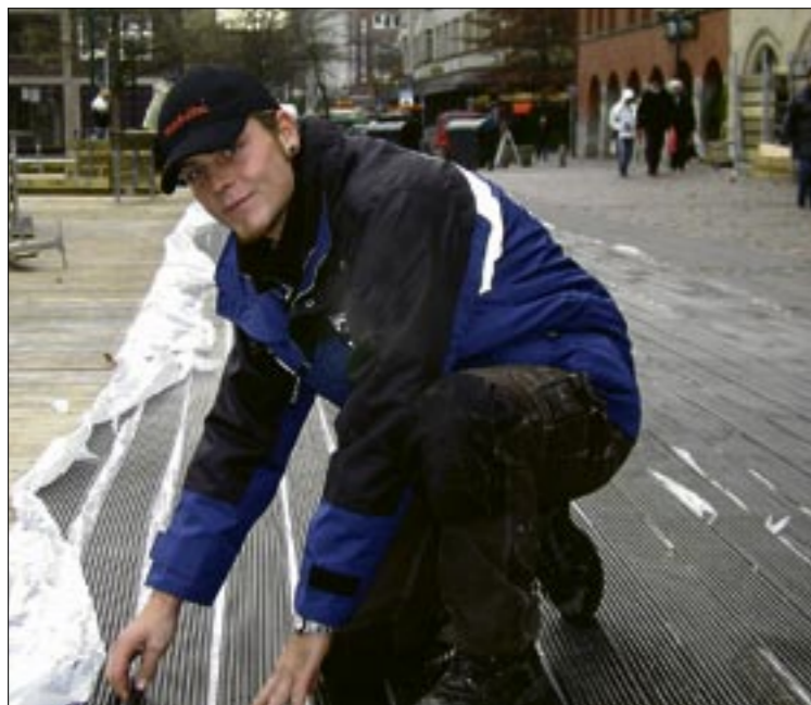
Jan Schleiffer verlegte insgesamt sieben Kilometer Kühlschläuche auf dem Kieler Rathausplatz.
