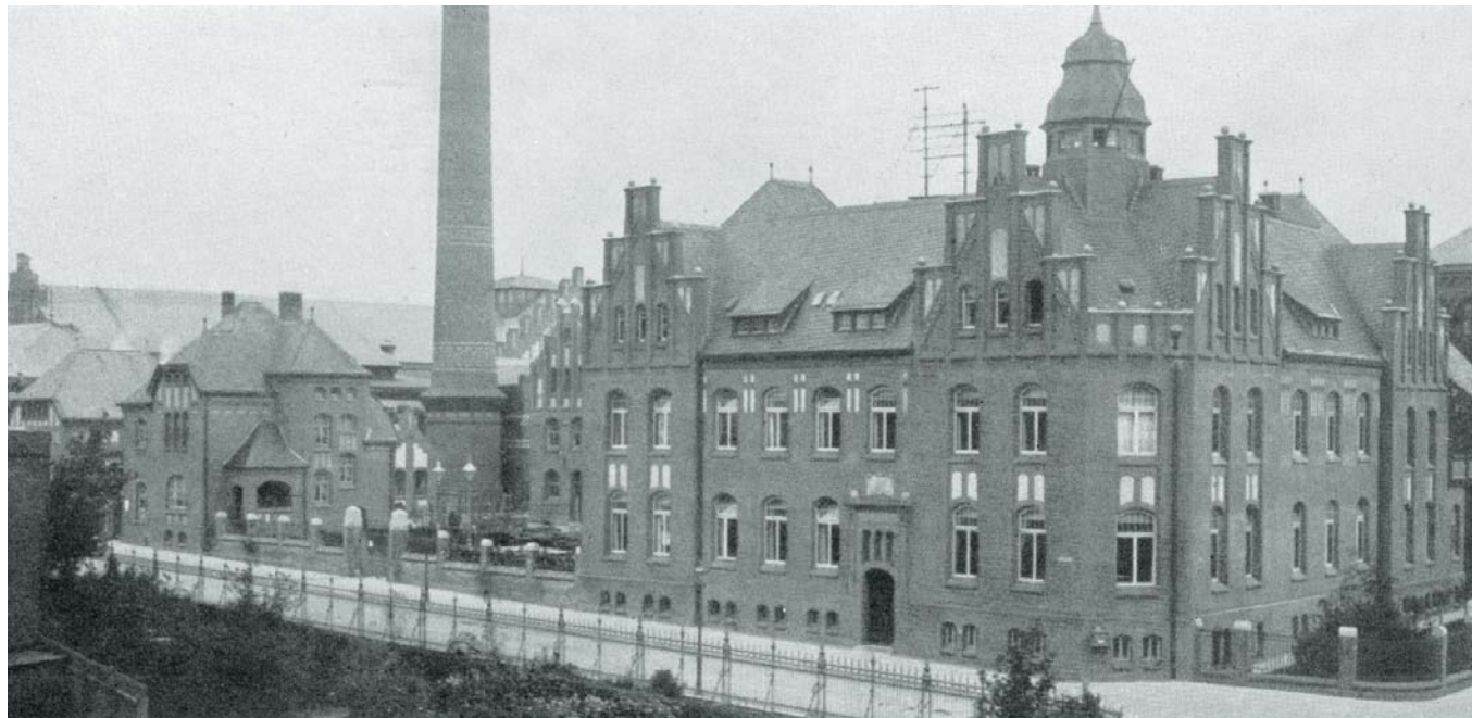
Städtisches Elektrizitäts- und Wasserwerk in Kiel, Goetbestraße - Ecke Humboldtstraße; Fernheizwerk
