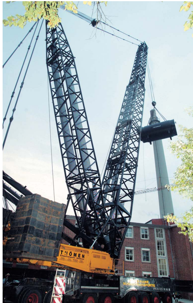
Rund 70 Meter hoch ragte der Ausleger des 800 Tonnen hebenden Krans über das Kraftwerk in der Humboldtstraße.
