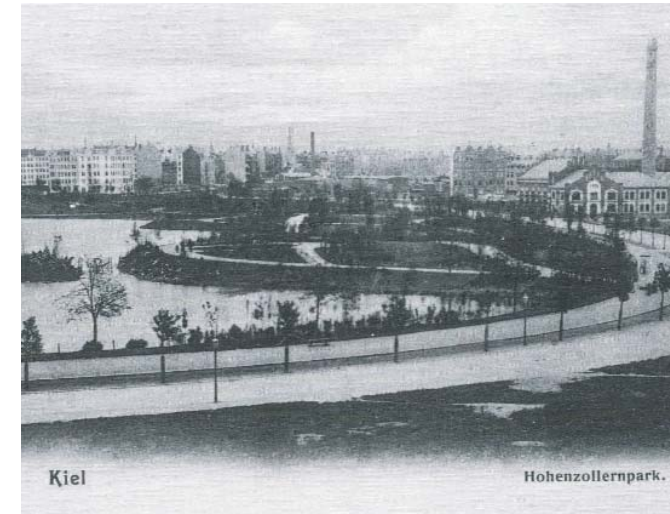
Direkt am ehemaligen Hohenzollernpark gelegen: das Fernheizwerk Kiel.
